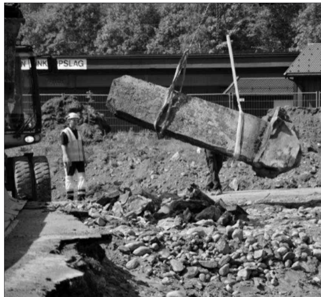
I forbindelse med veiarbeidet ved Tretten stasjon i år ble bautaen flyttet for så å settes opp igjen når arbeidet er ferdig. Foto: Stine Johansen-Solbraa
