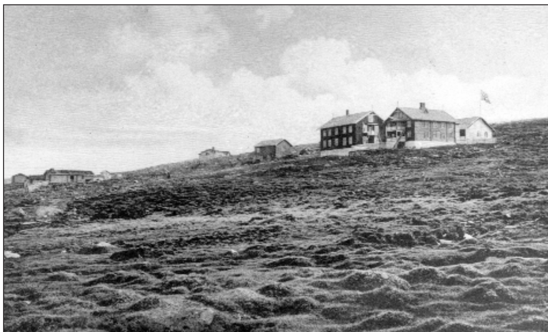
Hornsjö höyffellshotell (dengang sanatorium). Bare 3-4 bygninger den gang. Nermosetra til venstre.
