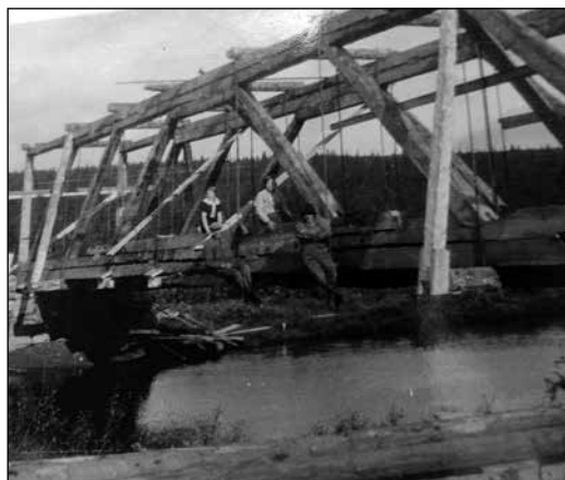
Bøseterbrua, Ivar Bræins brukonstruksjon.
