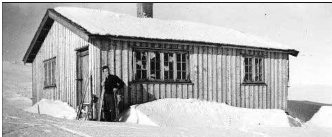
Pelle foran første byggetrinn.
