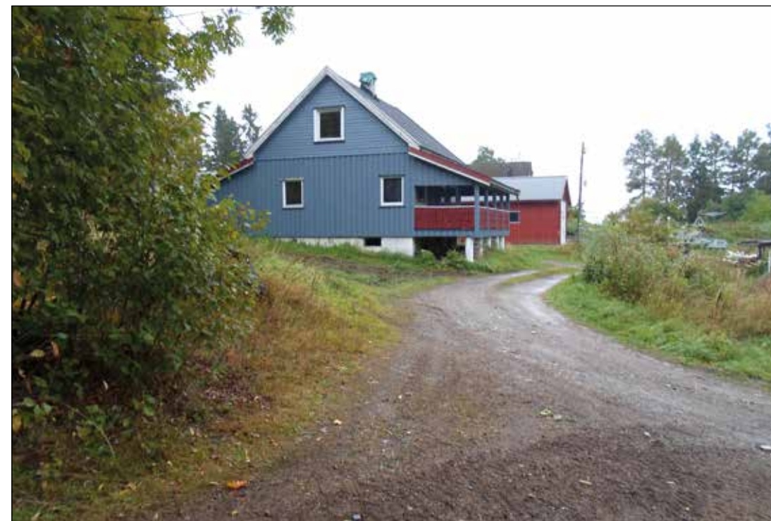
Bildet over viser Kønnløkka i dag. Bygningen er nå i langt bedre forfatning enn på den tida Jakob bodde der.
