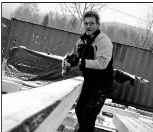
Dirk Meyvis hovelar tømmerstokker til restaureringen av Tretten kirke.
