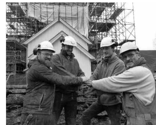
Restaureringen av Tretten kirke har i stor grad vært utført av utenlandske håndverkere. Alf Reidar Melvær Vadøy, til venstre, har blant andre hatt med seg franskmannen Thomas Bisch, tyskeren Jan Stigen og belgieren Dirk Meyvis på den mest omfattende restaureringen av en kirke i Gudbrandsdalen i nyere tid. (Foto: GD-arkiv – Einar Odden).
