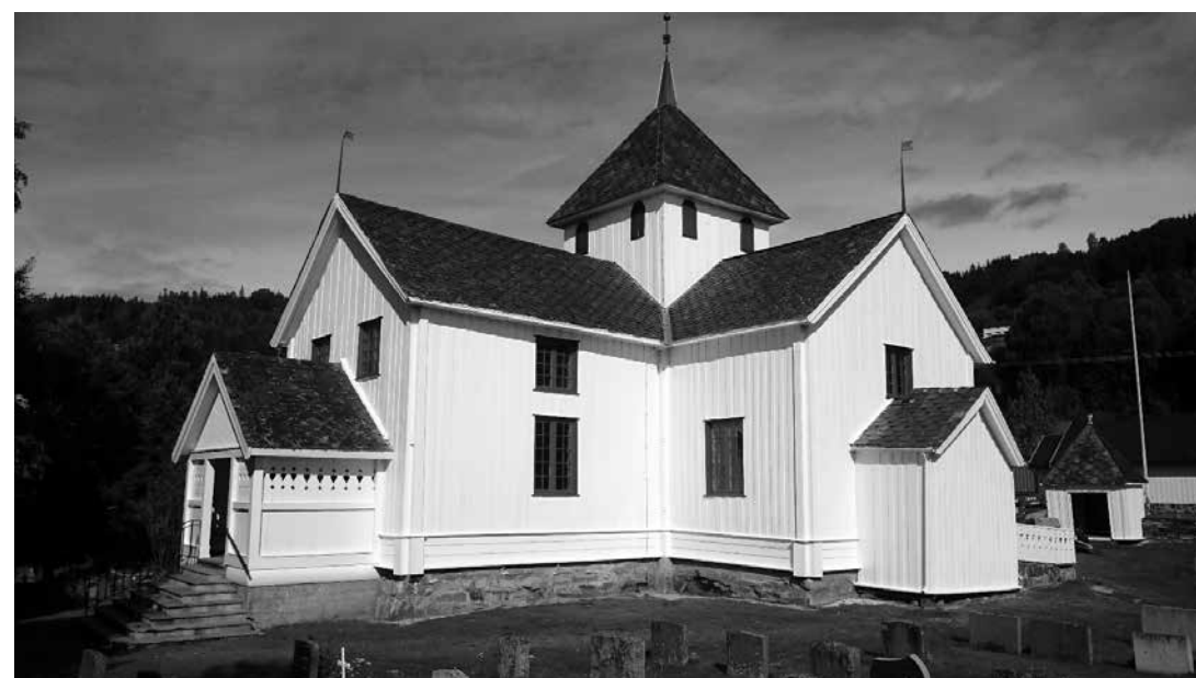
Tretten kirke er ferdig restaurert. Foto: Morten Brendløkken.
