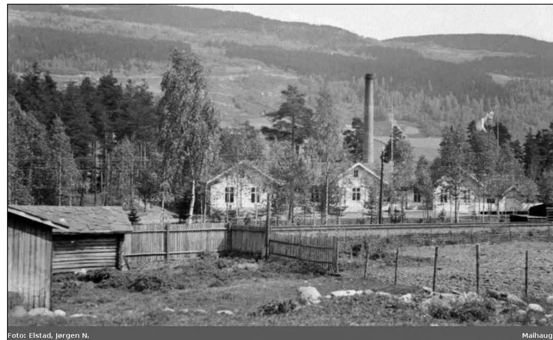
AS Gudbrandsdalens Caseinfabrik i slutten av 1920-årene.
