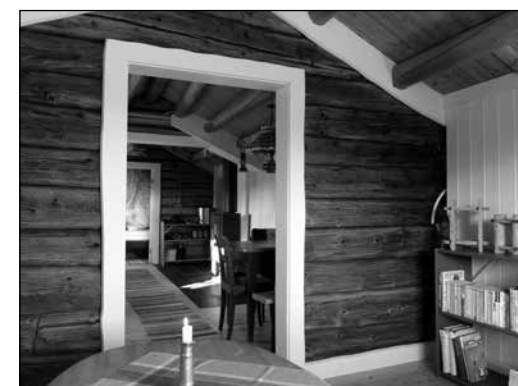
Innvendig møtes gammelt og nytt, slik det alltid har gjort på Hundberget. Vi kan lese historien i vegg og gulv, slik bildet viser. Her møter ny panel i kammerset den gamle værbitte ytterveggen i eldhuset, som nå har blitt innervegg i kammerset.
