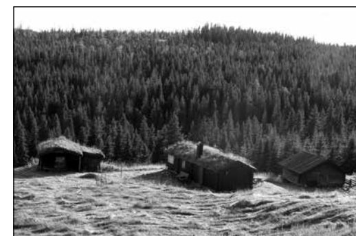
Setra slik den ser ut nå. Eldhuset ble bordkledt utvendig på 70-tallet, samtidig med at eldhuset, låven og stallen fikk torvtak. Fjøset fikk nytt tak på 90-tallet.
