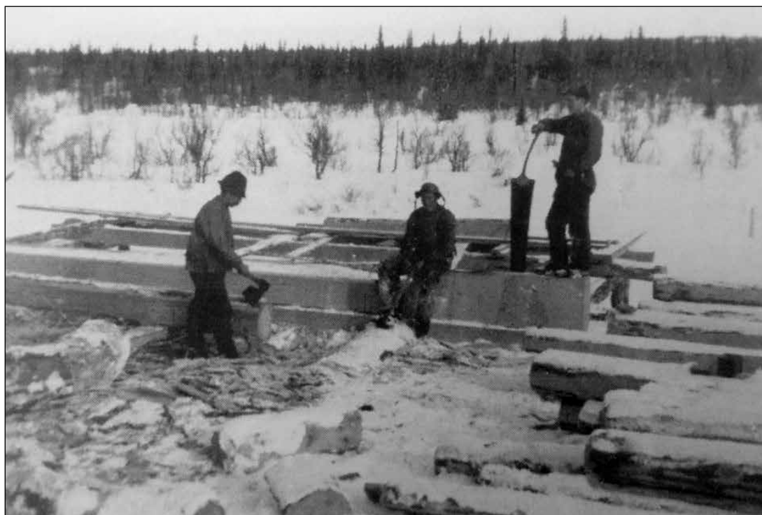
Byggingen av Bøseterbrua i 1928. På bilde ser vi Ivar Bræin, Sverre Bræin og Trygve Krukjordnet. (Foto: Ukjent).
