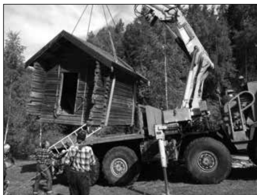
Kveinnhuset løftes på plass.
