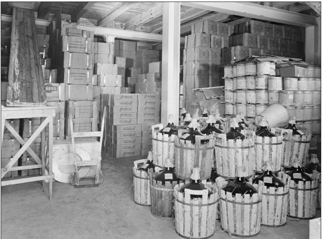
Varelageret i kkamrør Andersons mølle.
