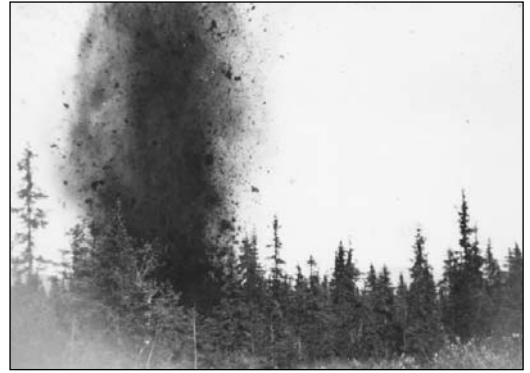
Skogsgrøfting med grøftedynamitt. Jordd og skog fikk seg en "luftetur" når dynamittsalva gikk av.
