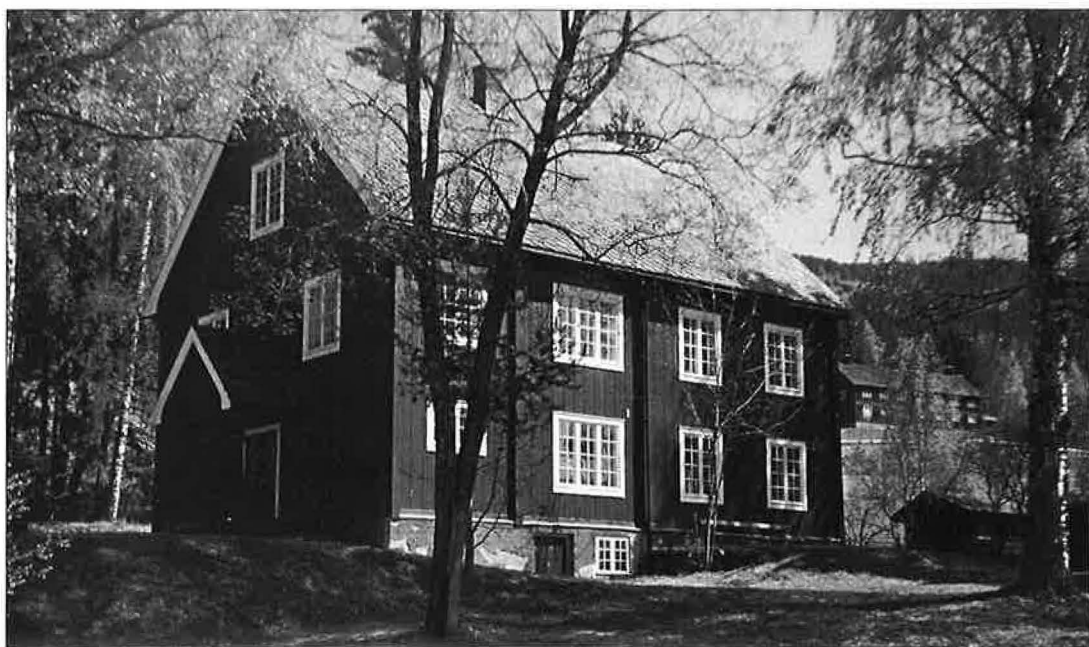
Misjonshuset på Tretten.
