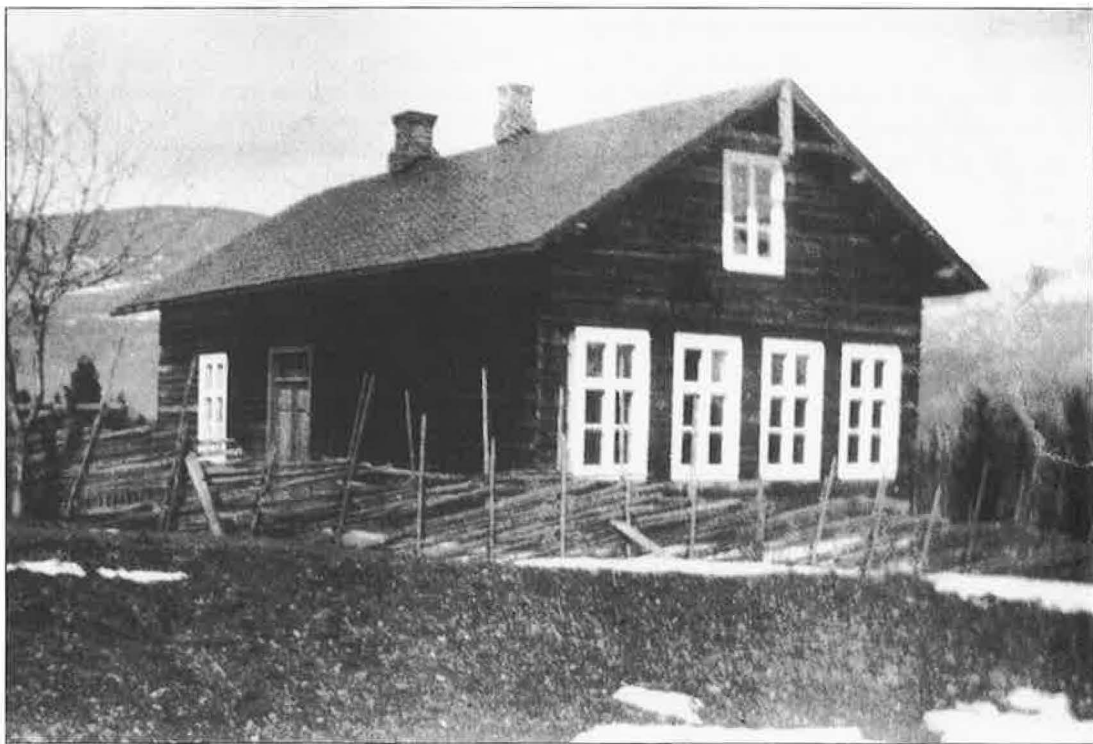
Vestlund skole i 1915. Huset ble bygd år 1900.
