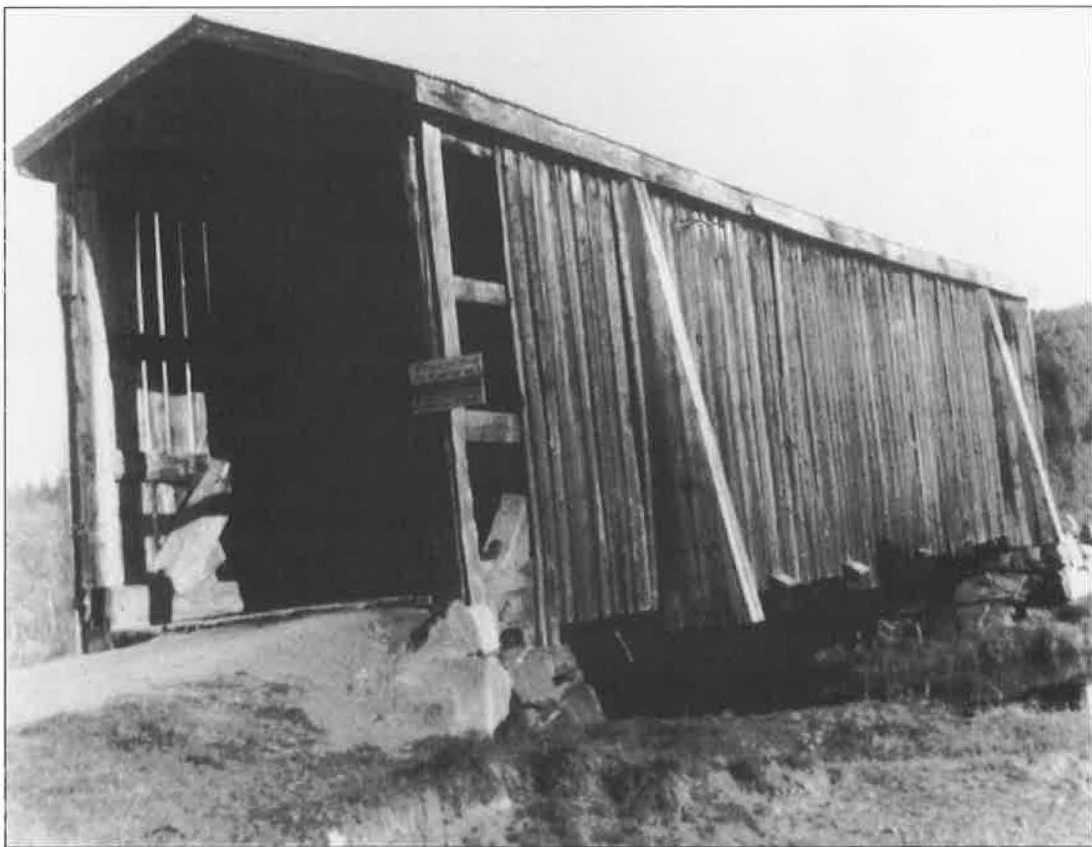
Bøs-brua i Åstdalen. Den ble tatt ned i 1978 og ligger nå lagret.
