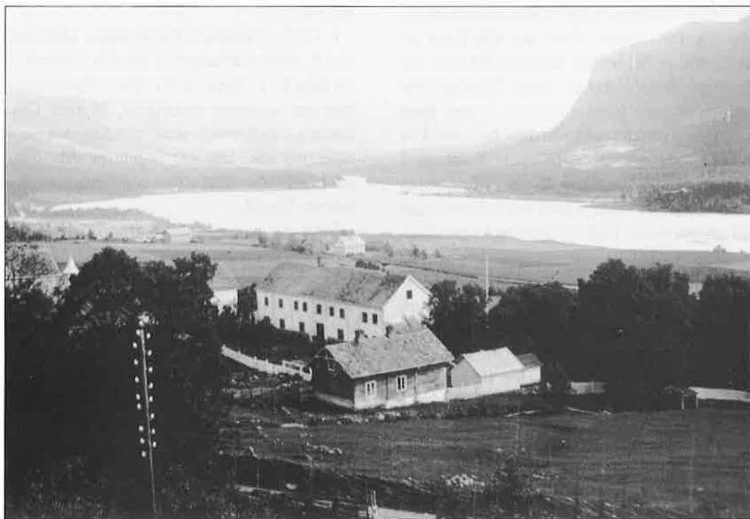
Øyer prestegard i 1905. Søre delen av hovudbygningen er den same som i 1730.
