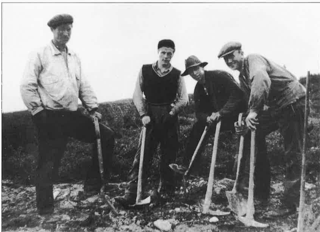
Bygging av setervegen fra Kjeiken, ned Kjeikslia til Augsetra. Arbeidslaget er fra høgre: Torleif Olstadjordet, Johannes Høgberg, Johannes Brekke og Kristian Kvardal.
