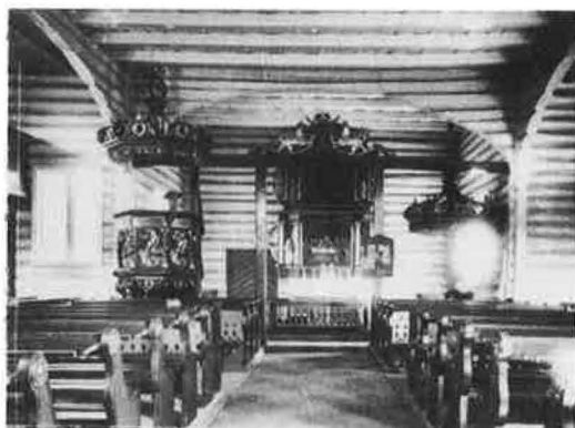
Interiør fra Tretten kirke. (Før 1900).
