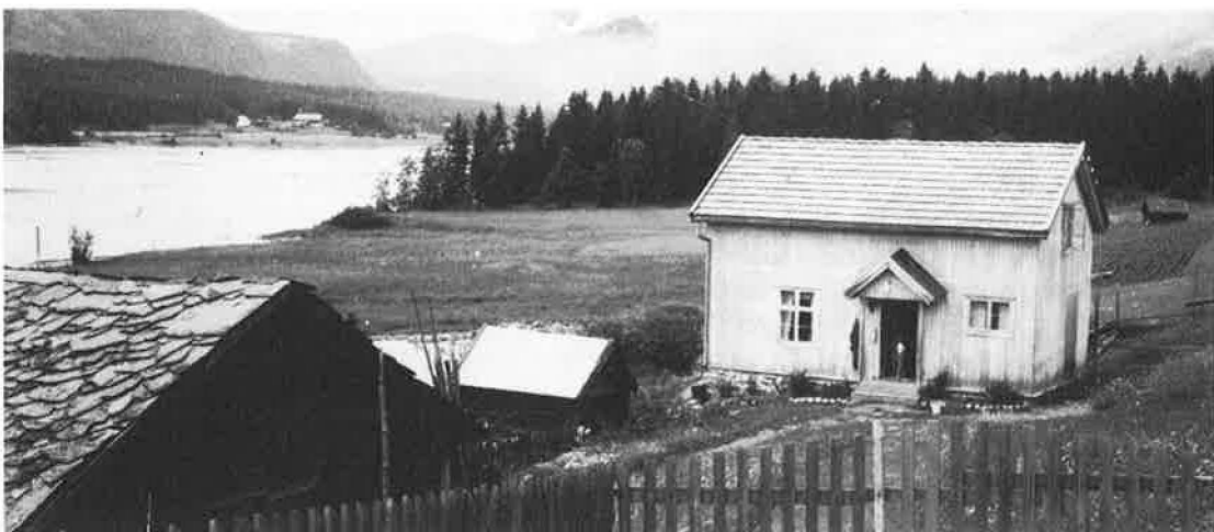
Langvik 1940. Bolighuset er reparert etter bomberystelsene, og får nytt tak og utvendig panel.
