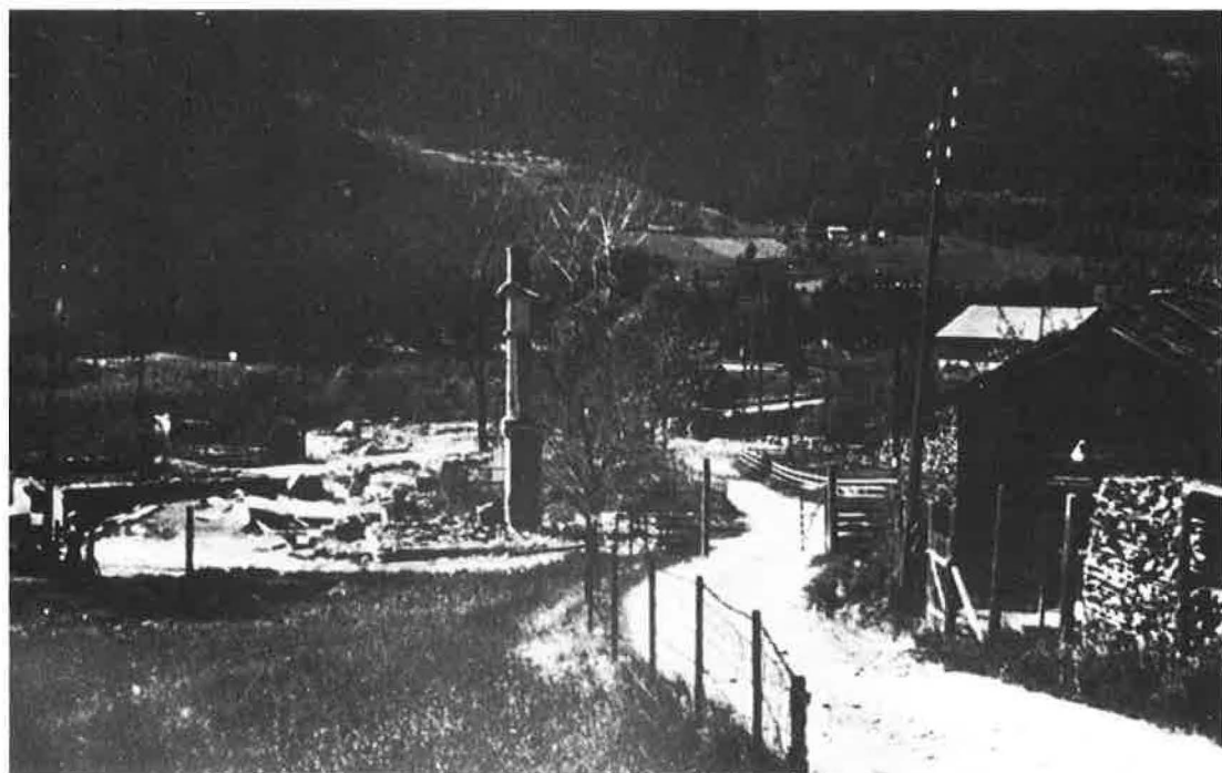
Fra Nustadgården. Pipa vi ser var fra den såkalte Badstugua. Fransstugua til høyre.
