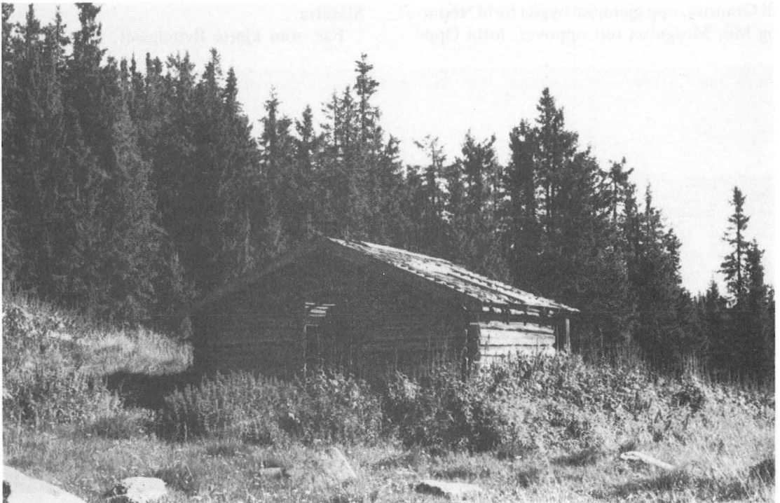
Kufjøset på Rybakk-setra – det eneste huset som står att på Slåsetra (1989). Foto: Ola T. Rybakken.
