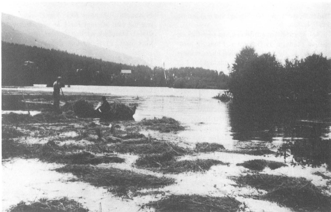
Fra lo-berging på Holmjordet under storflommen i 1938.
