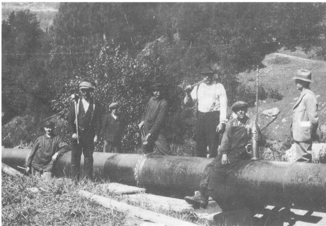
Montering av rørgata til Moksa Kraftanlegg. Bildet er fra Historielagets fotoregistreringsarkiv.
